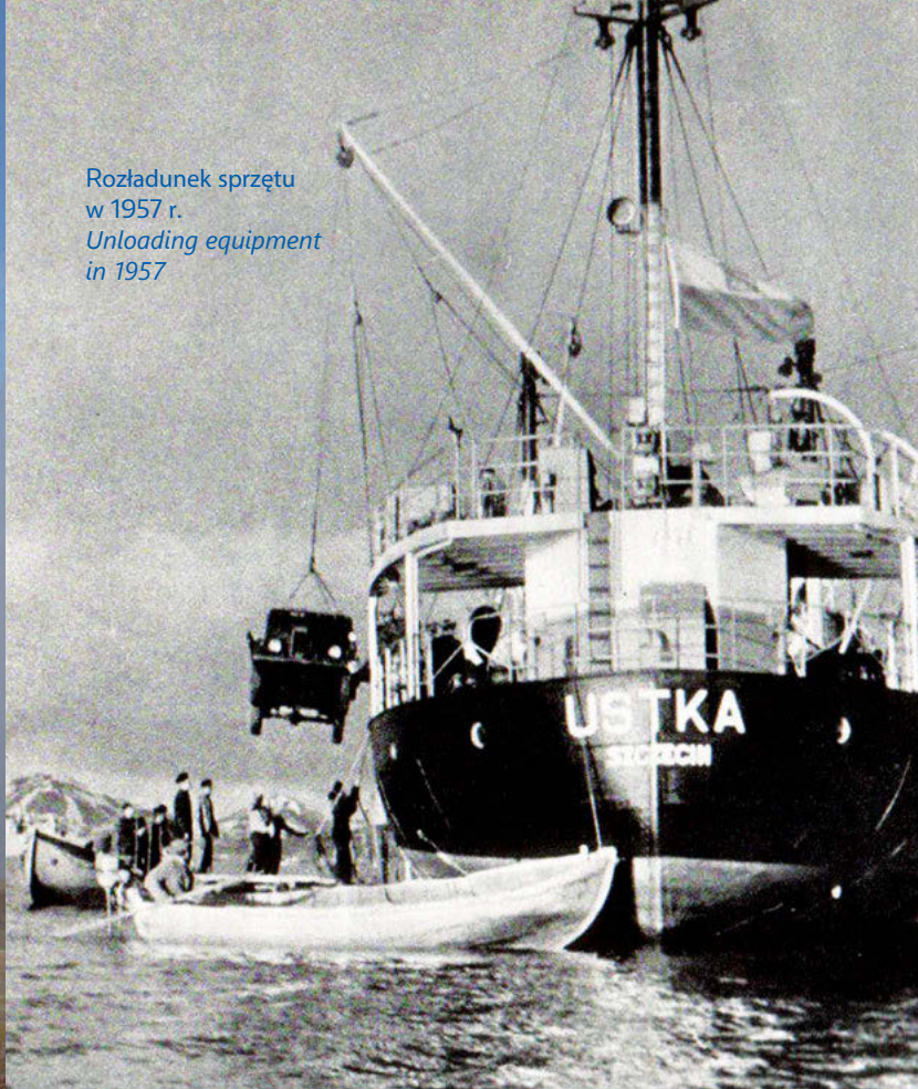
Budowa Stacji w 1957 r. Construction of the station in 1957
