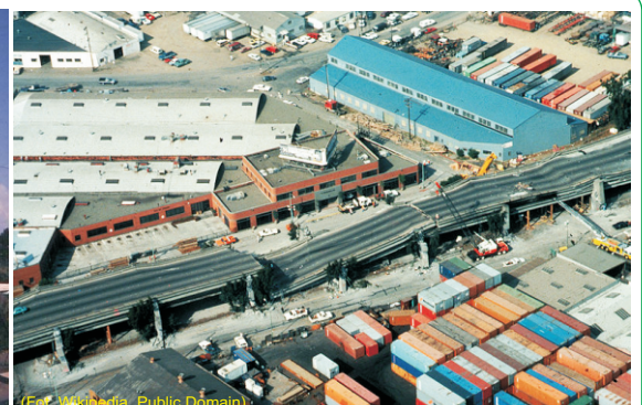
Loma Prieta (Kalifornia) 18 X 1989 M=6.9 Większość ofiar wstrząsu zginęła na starym wiadukcie z 1957 r. San Francisco - Oakland Bay Bridge.
